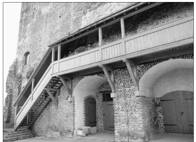
Der westliche Zugang zum Turm.
