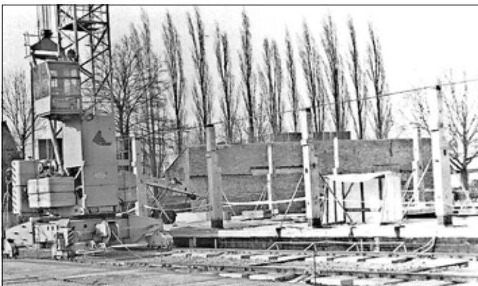
Die Baustelle in der Dammzollstraße 7 Anfang März 1981
