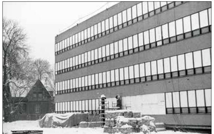
Der Rohbau des Ambulatoriums im Winter 1981/1982
