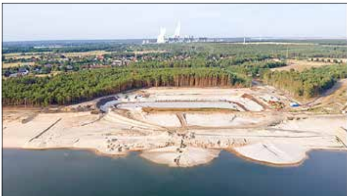
Seehafen Teichland im Bau mit den OT Neuendorf und dem Kraftwerk im Hintergrund. Foto: Harald Groba
