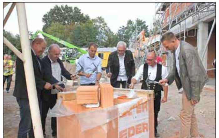
Bürgermeister Herr Krakow, Projektsteuerer Herr Kutzner - Gabriel, Vorhabenträger Herr Schaffer, Investor Herr Engler, der Zimmermann sowie der stellvertretende Bürgermeister Herr Schulz schlugen ersatzweise den letzten Nagel ein.
