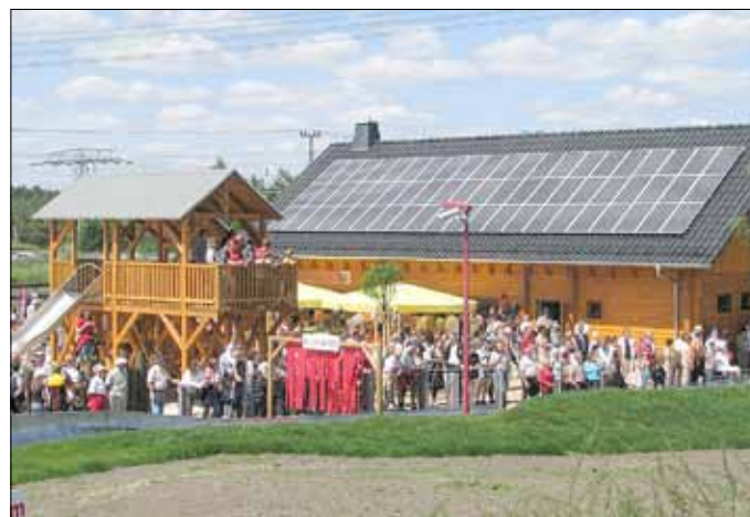
Begrünt, gestaltet, fertig - die Talstation zur Eröffnung am 25.05.2008.
