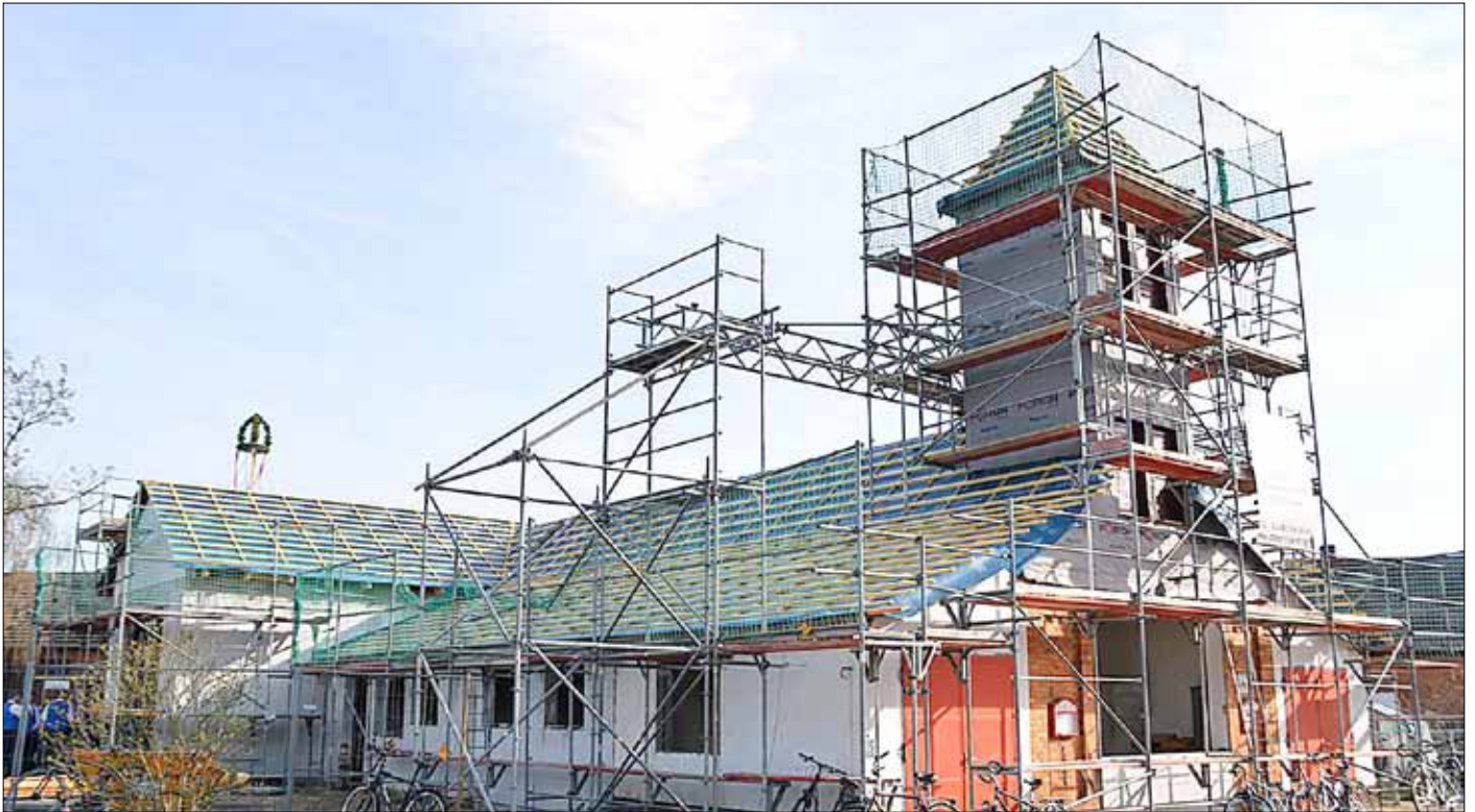
Am 31. März feierten die Kameraden der Ortswehr Turnow Richtfest am Feuerwehrgebäude.
