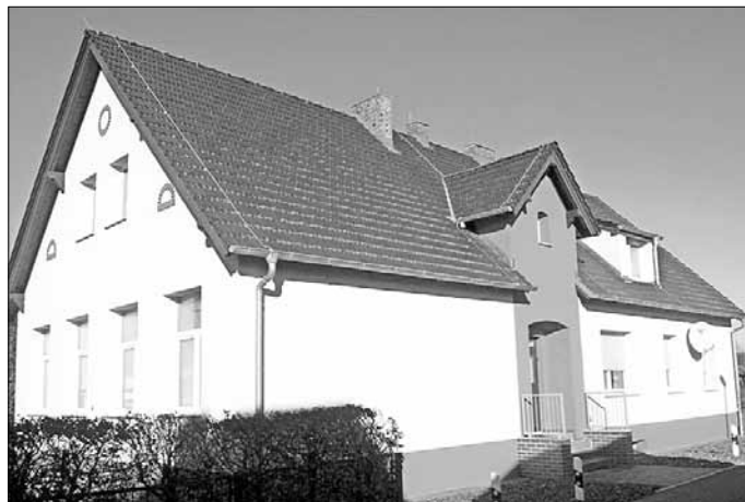
Wohnhaus nach der Fassadensanierung in Grieben
