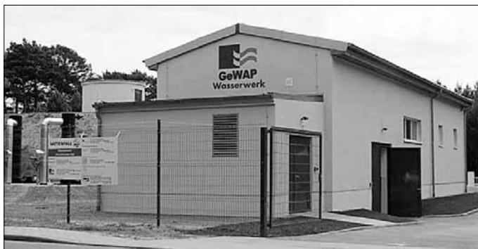
Unweit des Flugplatzes Drewitz steht das neue Wasserwerk
