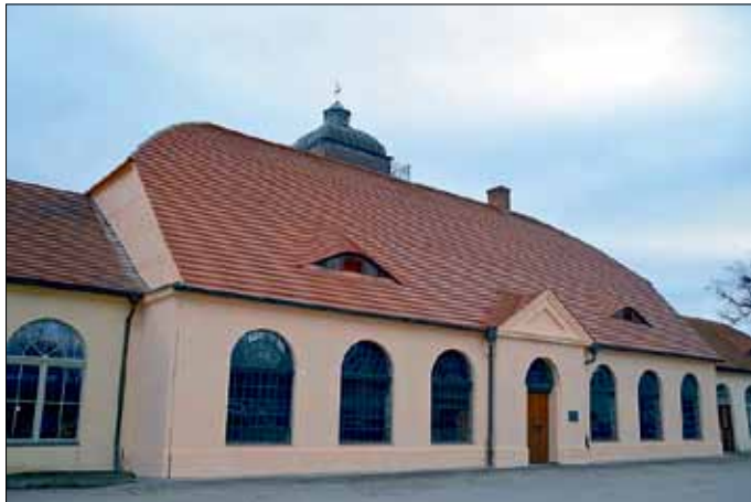
Bereich der Hochofenhalle nach der Sanierung
